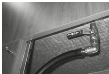
Lämpöaltaan tyhjennysventtiili
