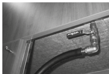
Lämpöaltaan tyhjennysventtiili
