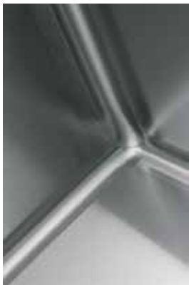
Altaan nurkat on pyöristetty ja viemärissä on roskasihti.
