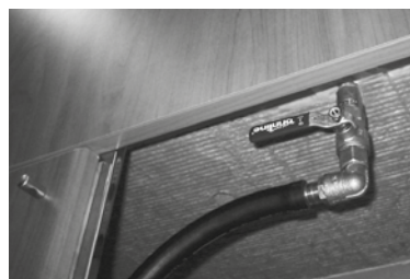
Lämpöaltaan tyhjennysventtiili
