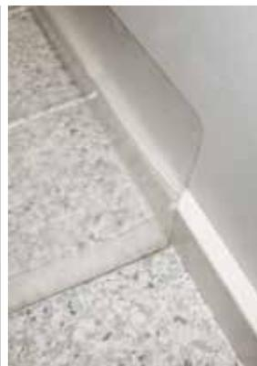
Vaihtoehtoisesti kylmiön sijoituspaikan voi tehdä vesitiiviiksi myös muulla tavoin. Vesitiivis alusta nostetaan seinälle niin, että mahdollinen vuotovesi ei pääse rakenteisiin lattian ja seinän liitoksen kautta.
