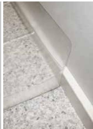
Det är också möjligt att göra underlaget vattentätt så, att ett eventuellt vattenläckage genast kan märkas. Det vattentäta underlaget böjs upp mot väggen så, att ett eventuellt vattenläckage inte kan rinna in i konstruktionerna genom fogen mellan golv och vägg.
