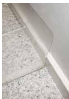
Vaihtoehtoisesti kylmien sijoituspaikan voi tehdä vesitiiviaksi myös muulla tavoin. Vesitiivis alusta nostetaan seinälle niin, että mahdollinen vuotovesi ei pääse rakenteisiin lattian ja seinän liitokseen kautta.
